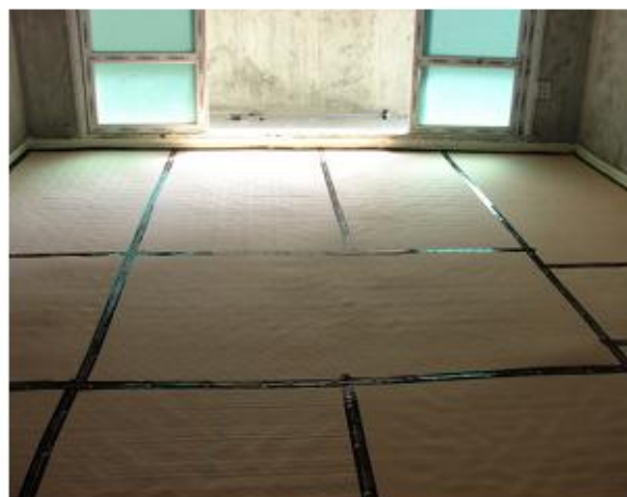
(e) 완충재(멀티블럭Ⅲ)의 설치완료
