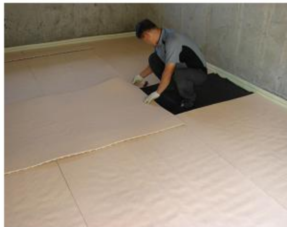
(d) 완충재(요철포함 EVA FOAM_상부) 설치
