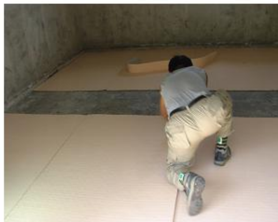
(b) 완충재(요철포함 EVA FOAM_하부) 설치
