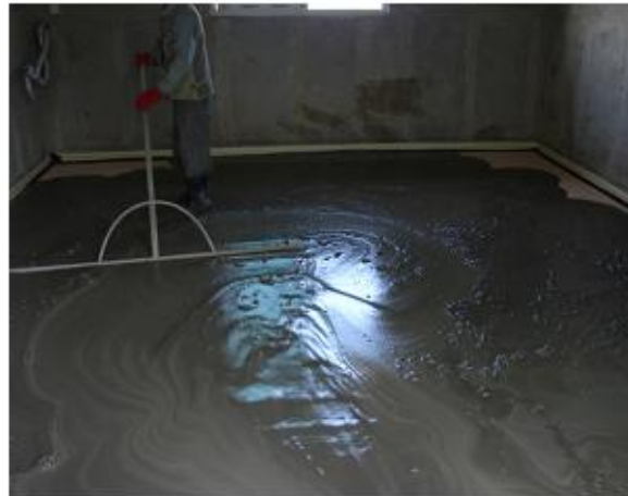
(f) 경량기포 콘크리트 타설
