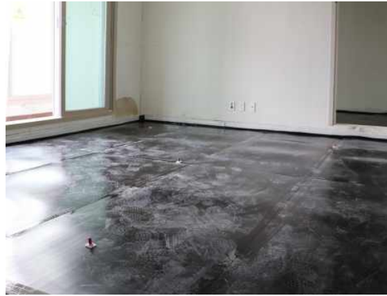
(b) 완충재(로벨 J-40) 시공
