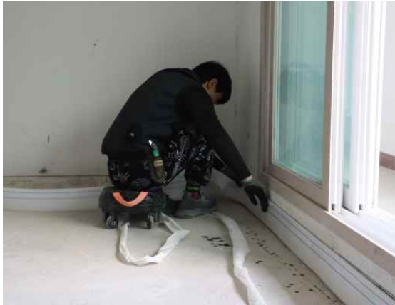
(a) 측면완충재 시공
