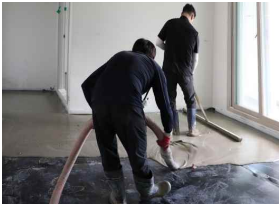
(c) 경량기포콘크리트 타설
