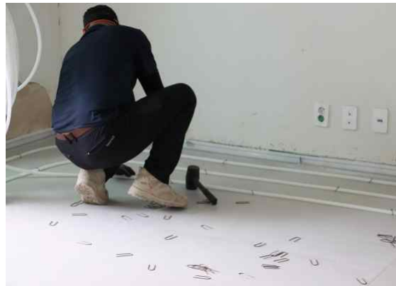
(d) 난방배관 설치
