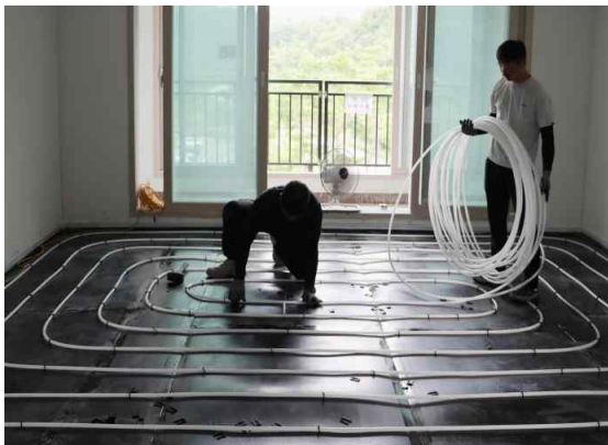
(c) 난방배관 설치
