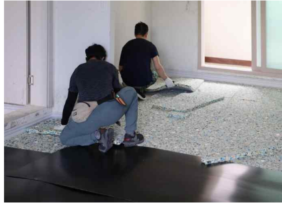
(b) 완충재(로벨 J-55) 시공
