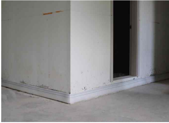
(a) 측면완충재 시공
