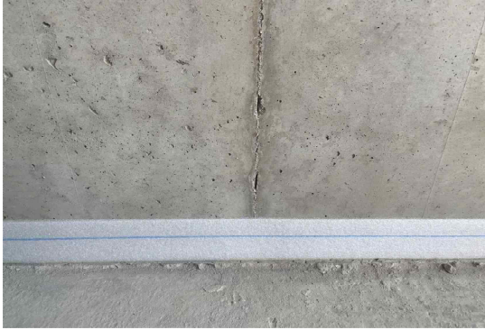
(a) 측면완충재 시공
