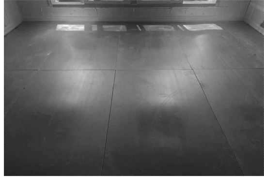
(b) 완충재 시공
