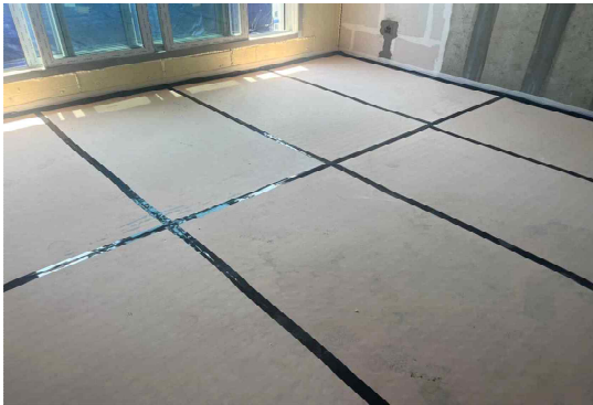
(c) 완충재 시공
