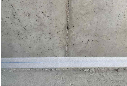
(a) 측면완충재 시공
