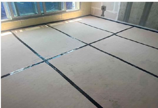
(c) 완충재 시공
