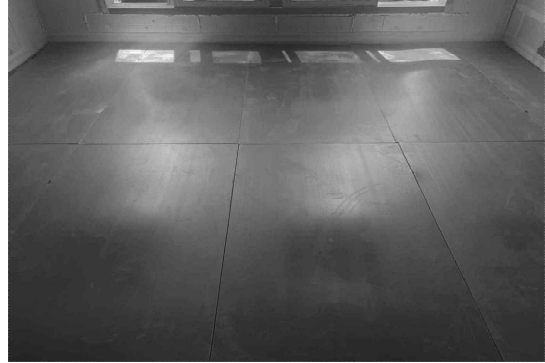
(b) 완충재 시공
