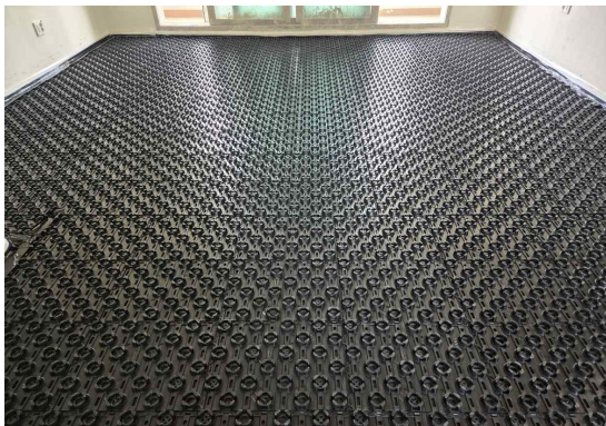
(c) 난방배관 지지재 시공
