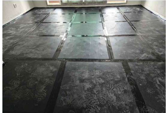
(b) 소닉스 U325 완충재 시공
