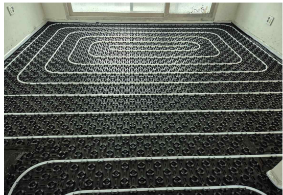
(d) 난방배관 설치
