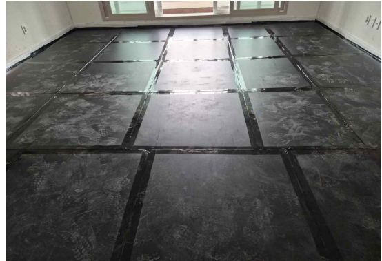
(b) 소닉스 U325 완충재 시공
