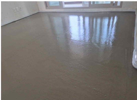
(c) 경량기포콘크리트 타설
