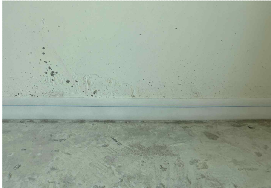
(a) 측면완충재 시공
