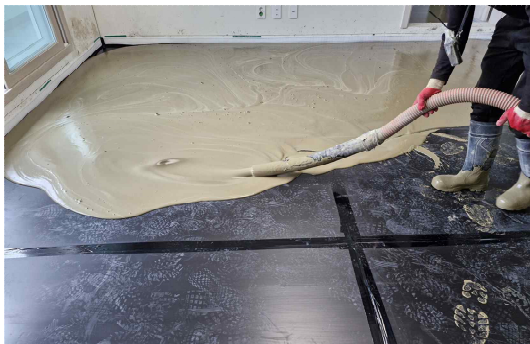
(e) 경량기포콘크리트 타설
