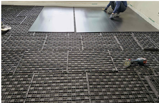
(c) 완충재 시공
