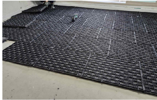
(b) 완충재 시공
