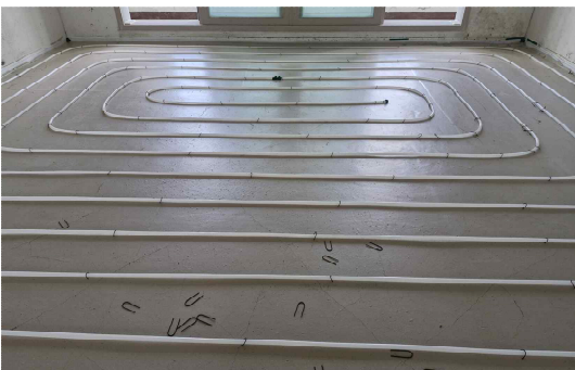
(g) 난방배관 설치
