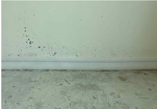
(a) 측면완충재 시공
