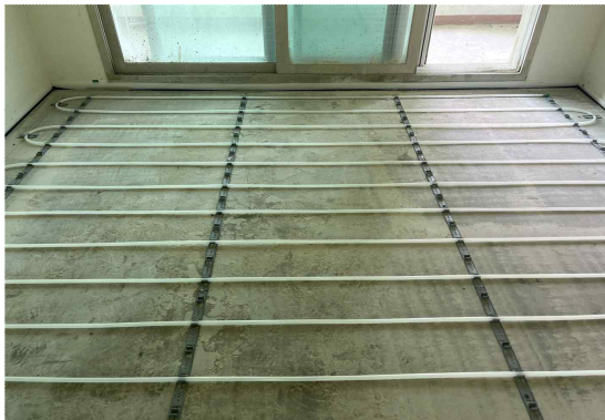
(g) 난방배관 설치
