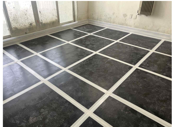
(b) 완충재 시공
