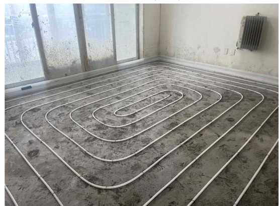
(d) 난방배관 설치
