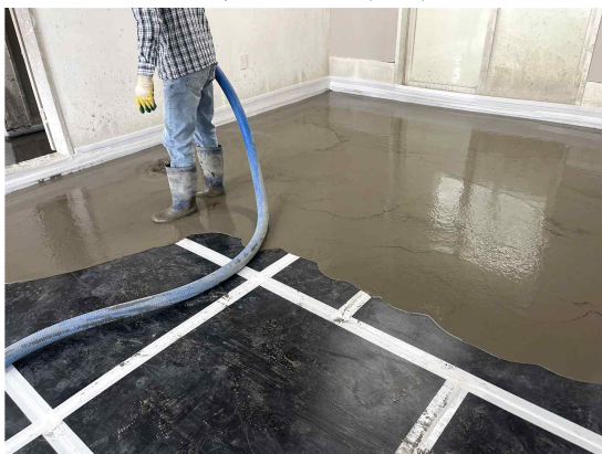
(c) 고점탄성모르타르 시공
