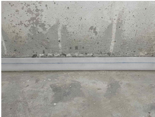
(a) 측면완충재 시공
