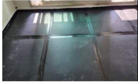
(b) 아파트A 완충재 시공
