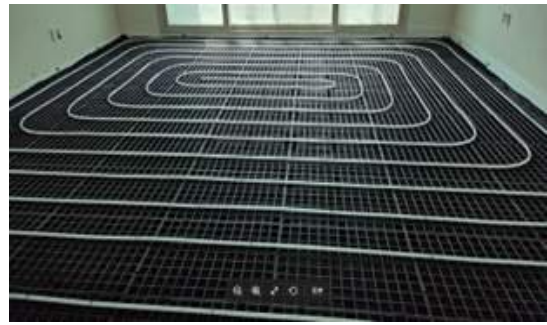
(d) 난방배관 설치
