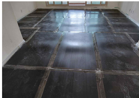
(d) 차수시트 시공
