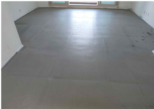
(e) 경량기포콘크리트 타설완료
