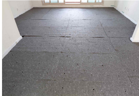
(b) 흡음단열재 시공
