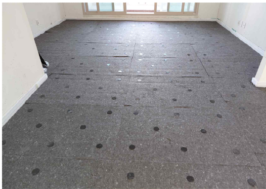
(c) 방진스프링 및 스프링하우징 시공
