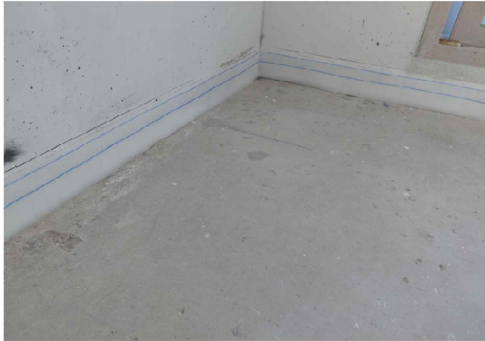
(a) 측면완충재 시공
