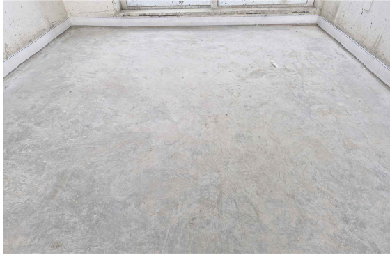
(a) 측면완충재 시공
