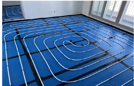
(d) 난방배관 시공
