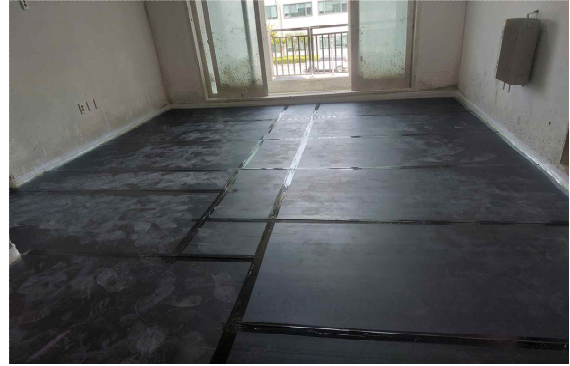
(b) KG복합완충재 시공
